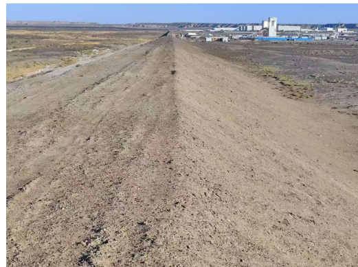
防洪堤土地平整及洒水
